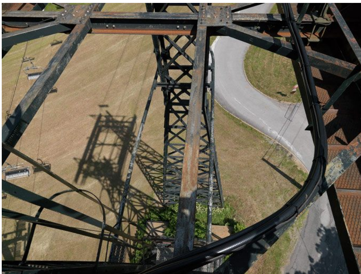
Détail du pylône
