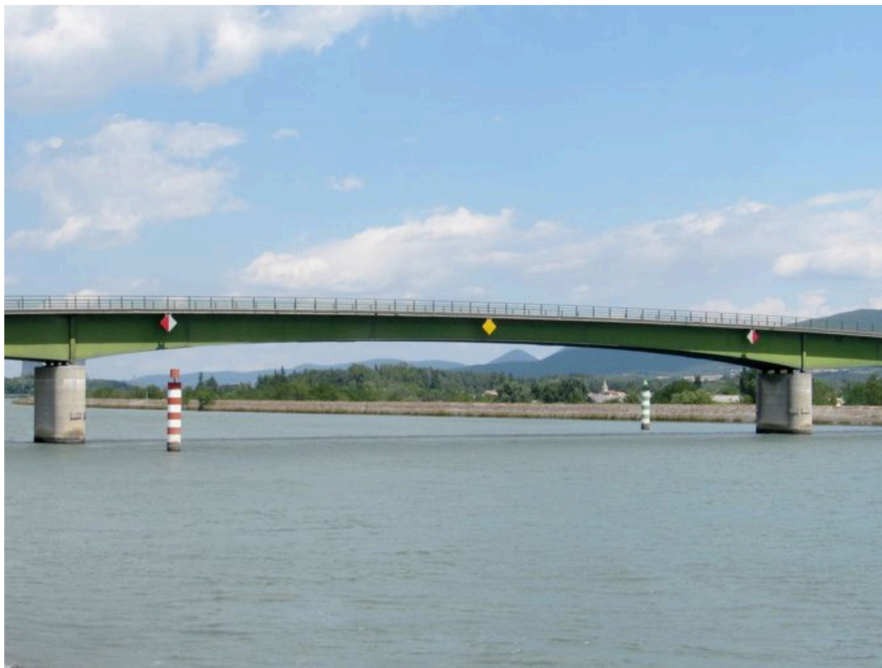
Vue partielle, travée centrale, face aval (depuis la rive droite)
