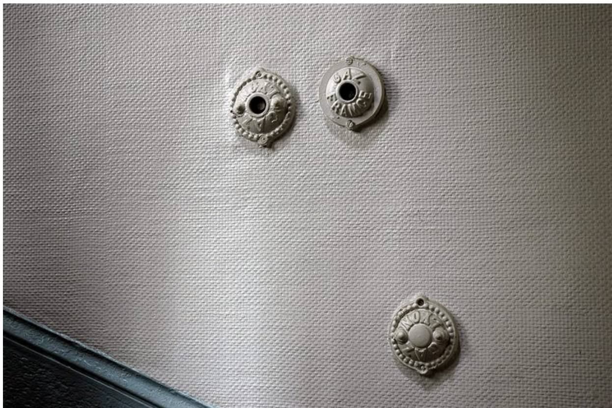
Cage d'escalier : détail
