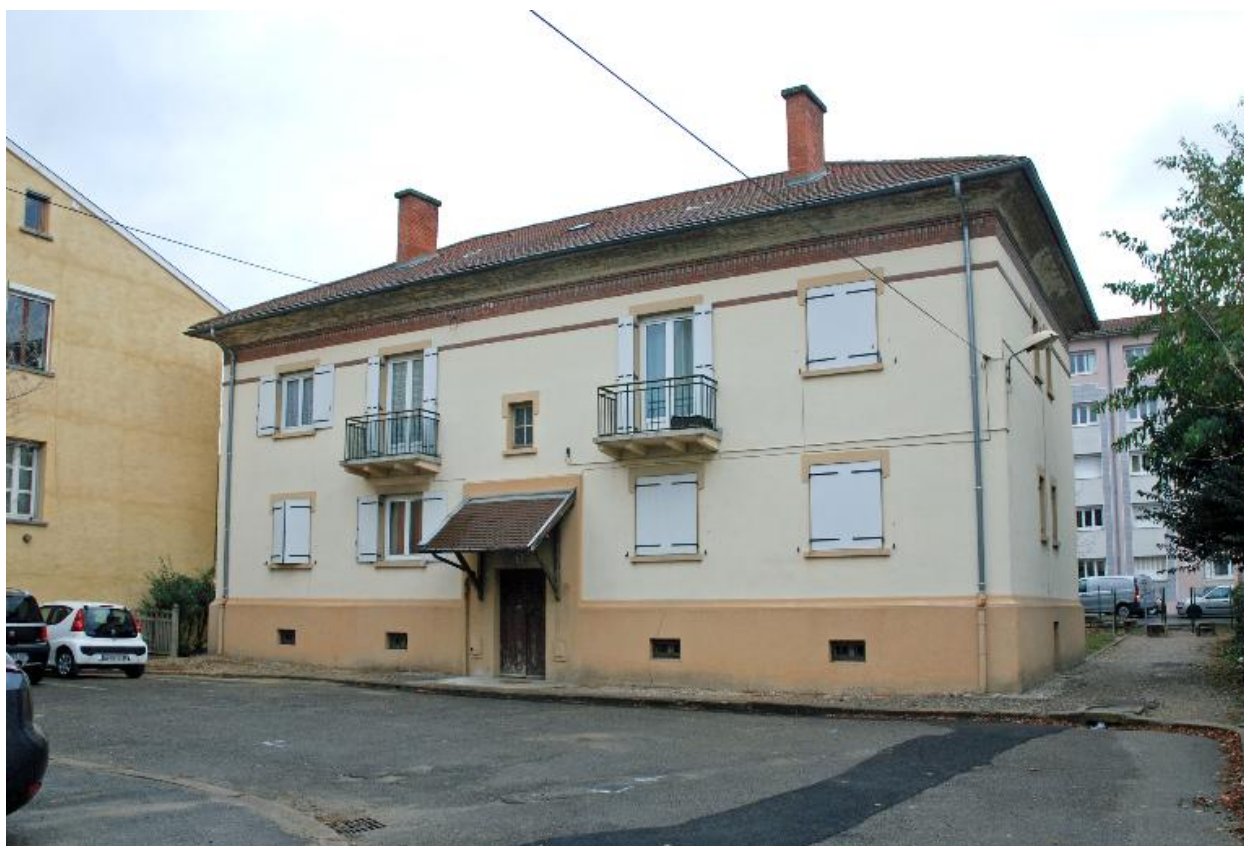
2e immeuble sur cour
