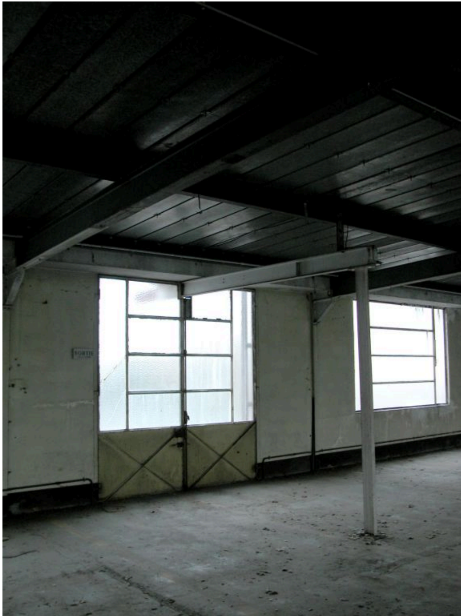
Elément de charpente de l'aile nord de l'usine.
