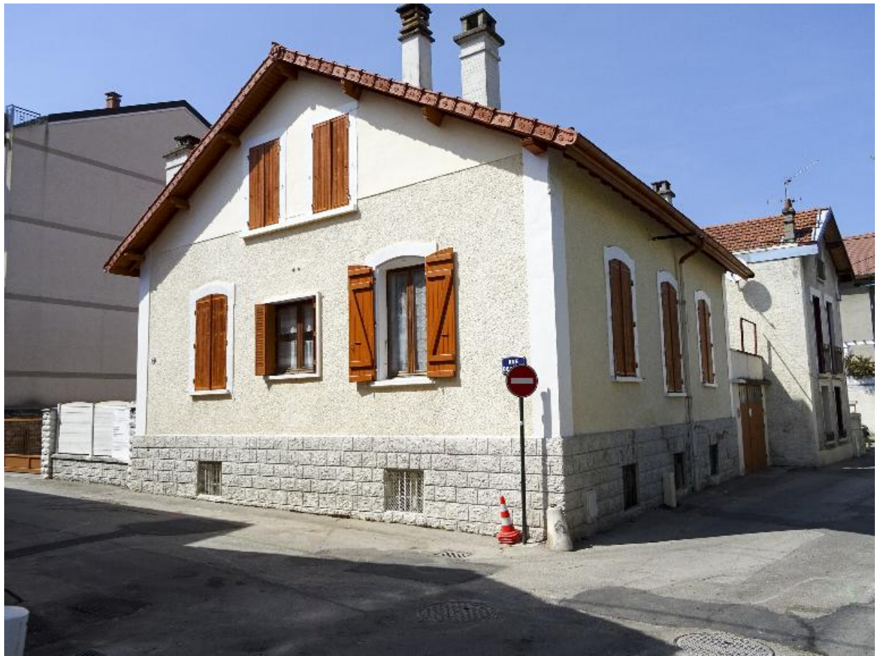
Façades sud (sur rue de Tunis) et est (sur rue du Maroc)
