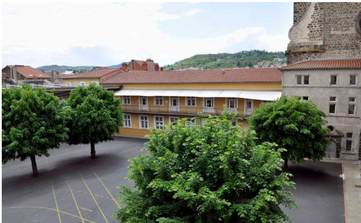
Bâtiment C : vue d'ensemble sur cour 2, depuis l'est
