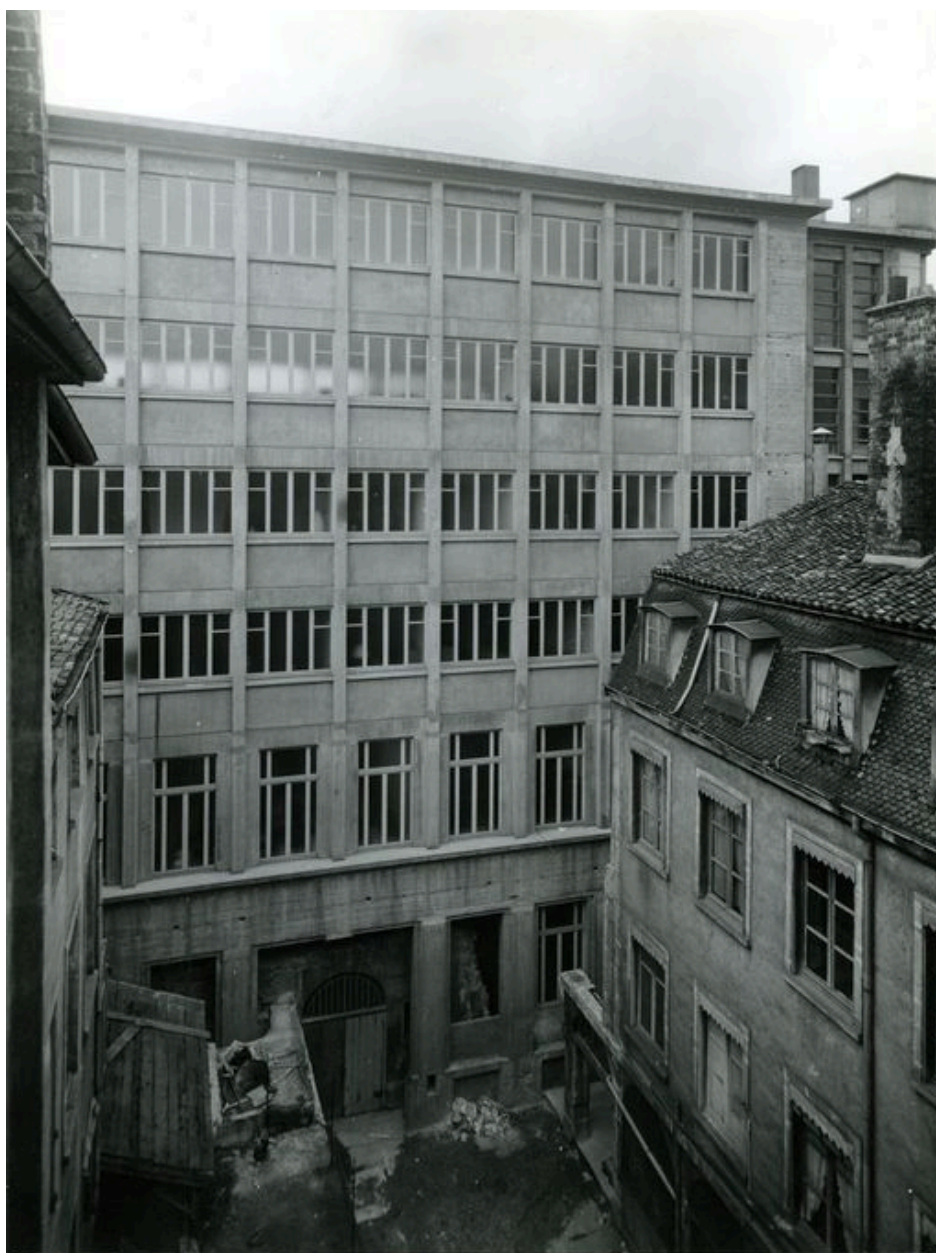
Elévation antérieure du bâtiment Isara (1ère tranche), cour du 12 rue Alphonse Fochier avant démolition, photographie ancienne, ca 1970
