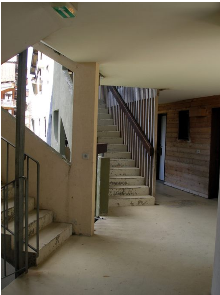
Départ des escaliers
