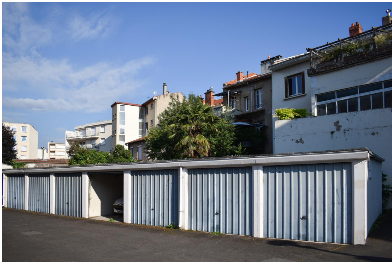
Elévations postérieures et garages
