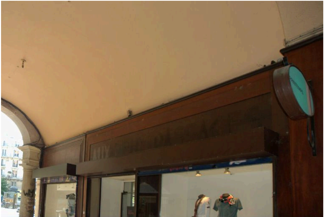
Détail de l'inscription AUX DEUX PASSAGES, sous la voûte du passage d'entrée
