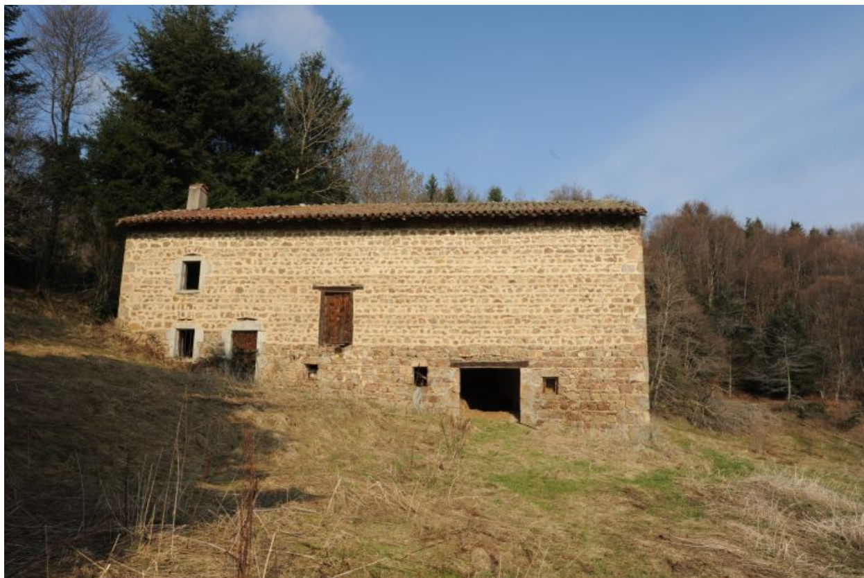
Vue d'ensemble du mur gouttereau sud.
