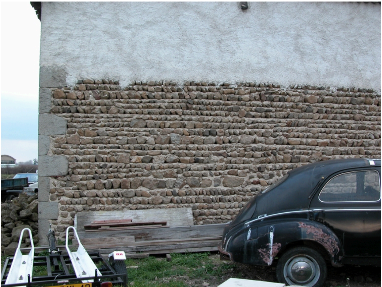
Détail de matériaux (ancienne ferme, Aux Jacquins, 1997 BK 90).
