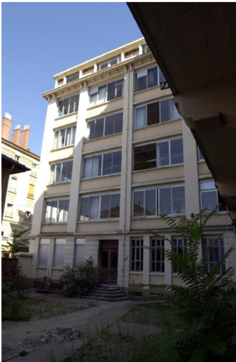
Vue du bâtiment des années 20
