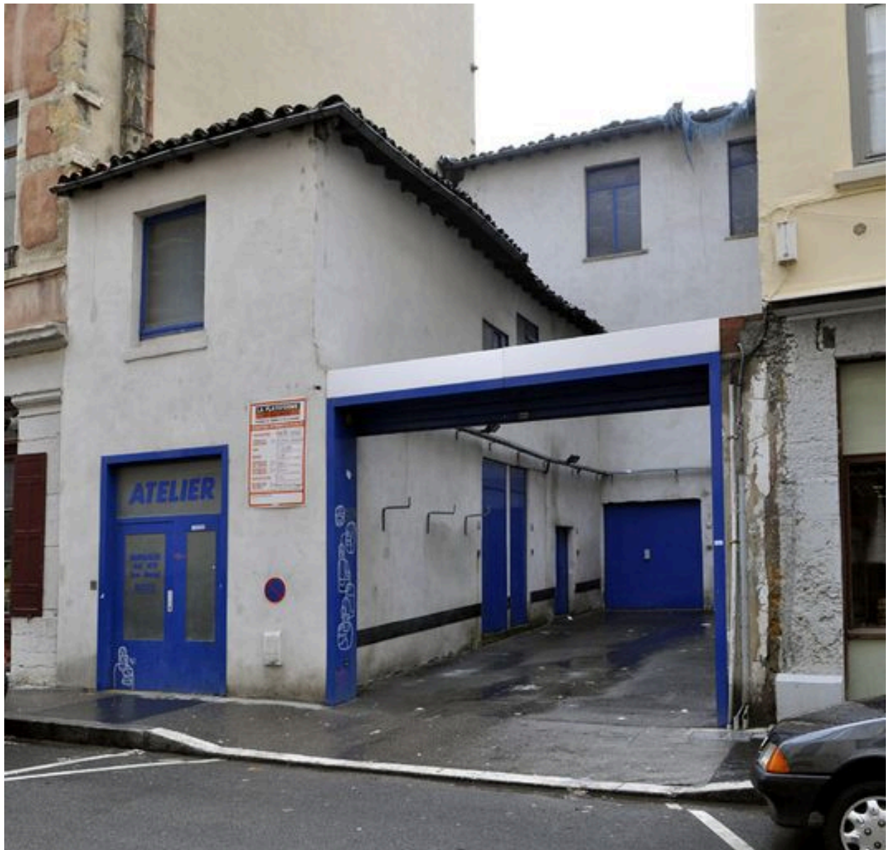
Vue de l'ancien atelier.
