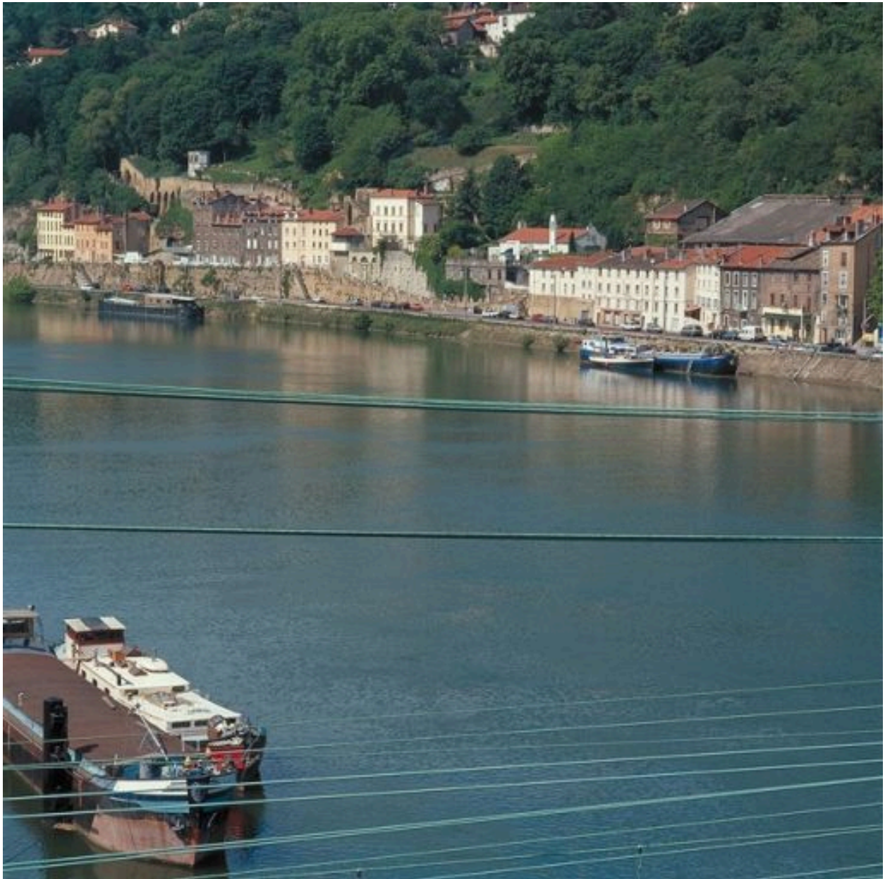
Vue d'ensemble vers le sud depuis le poste d'aiguillage 1 de Lyon-Perrache
