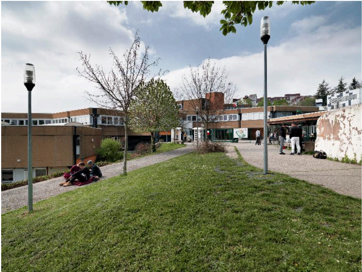
Vue d'ensemble du lycée depuis le parvis d'entrée, au débouché de la passerelle
