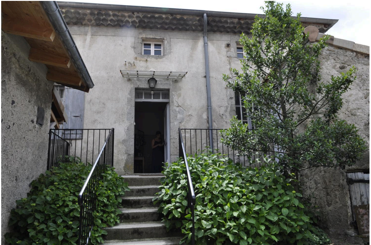
Entrée de l'habitation et bureaux
