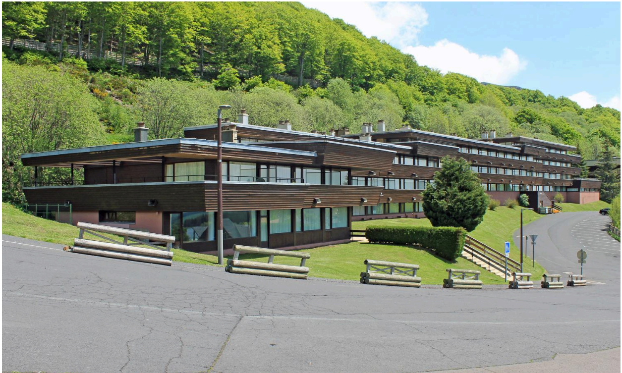
Au pied de la Tour de la Biche, la résidence La Forêt vue depuis l'ouest (architectes Faye et Tournaire).
