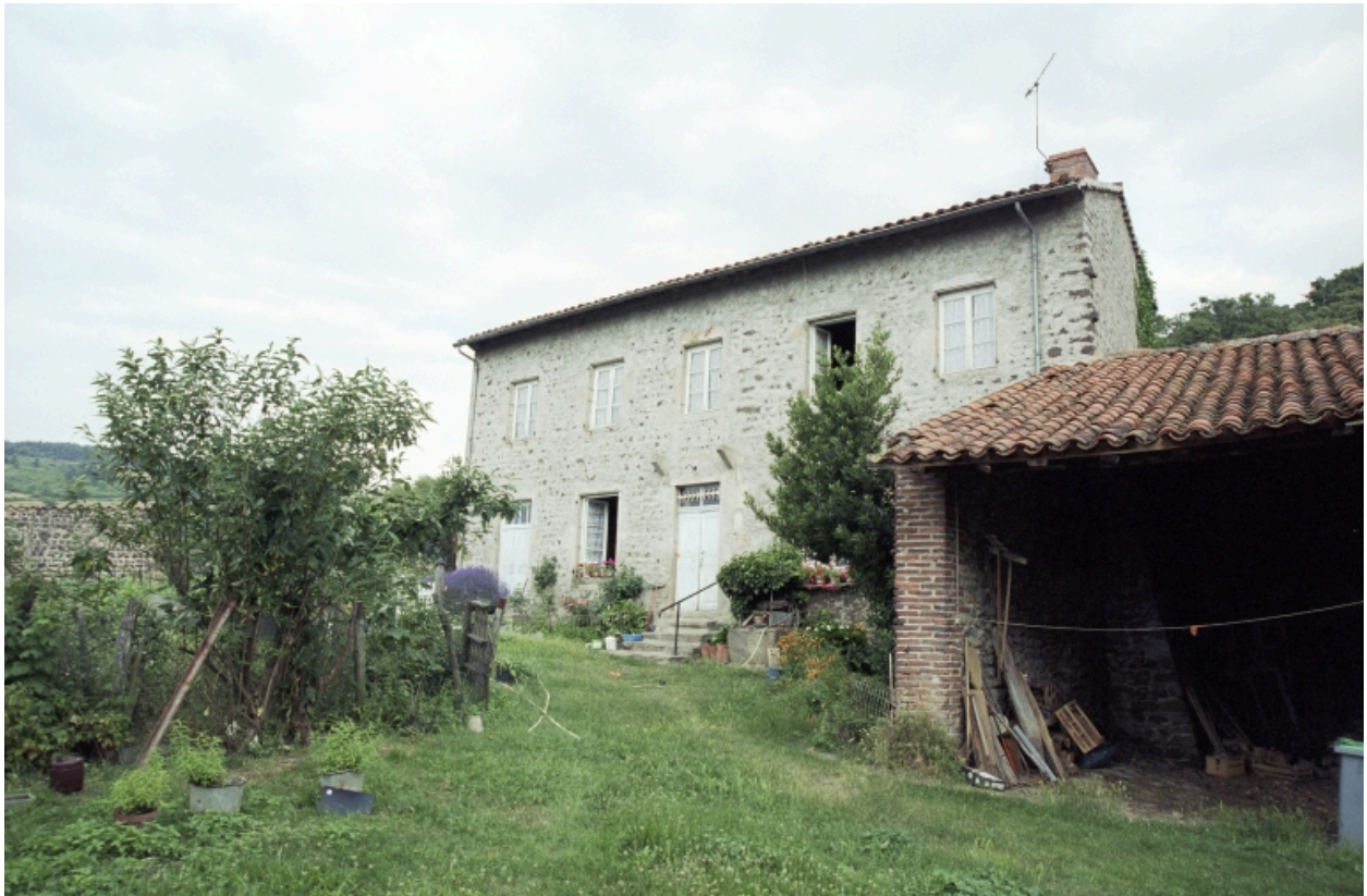
Marcilly-le-Châtel, le bourg (1987 A1 422-424), type B2. Vue d'ensemble du logis et du hangar depuis la cour.
