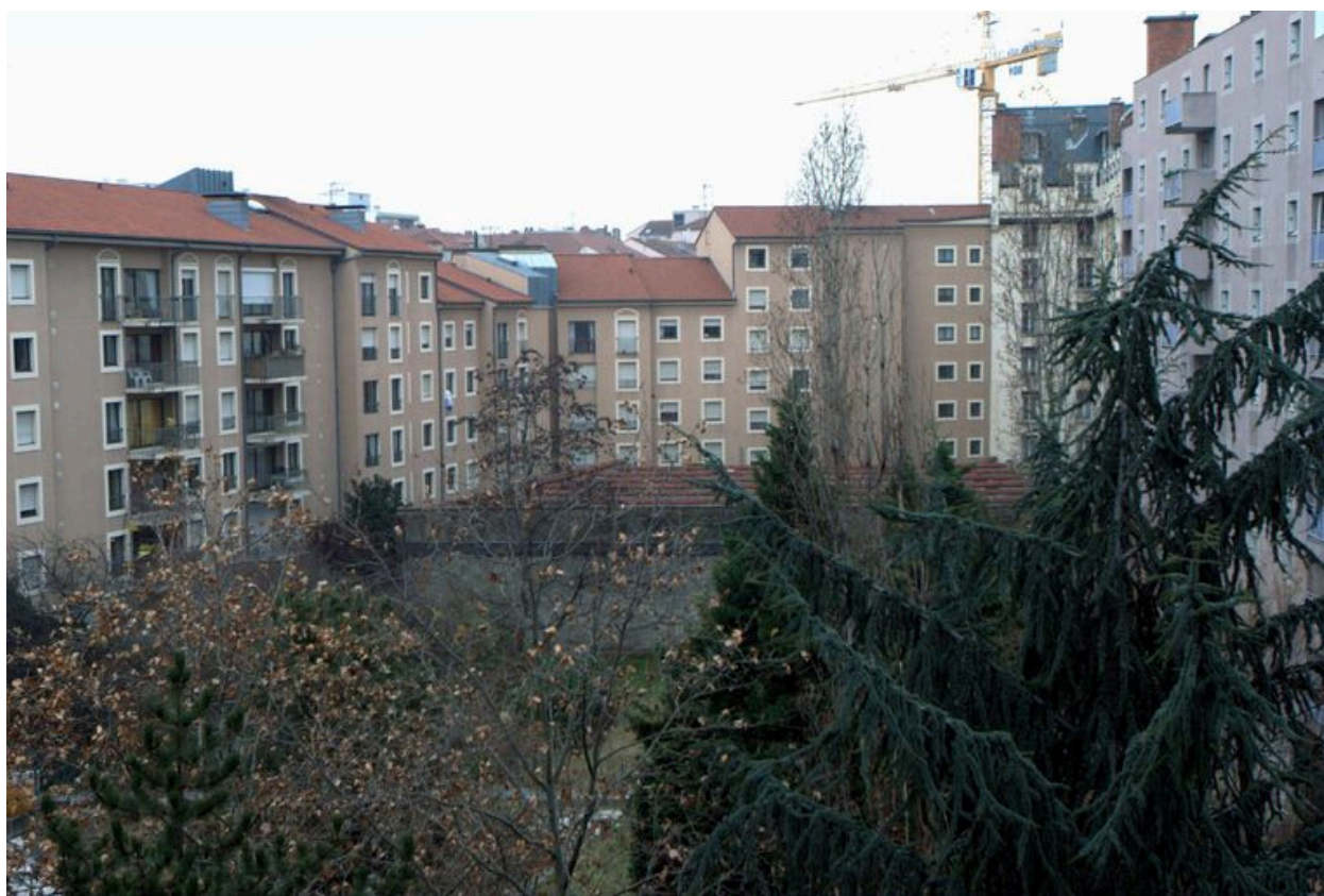
Elévations postérieures depuis le nord-ouest
