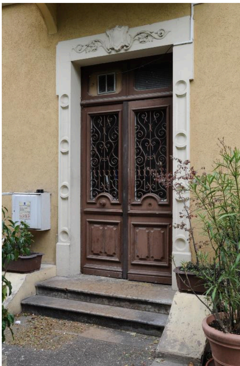
Porte d'entrée sur la façade est
