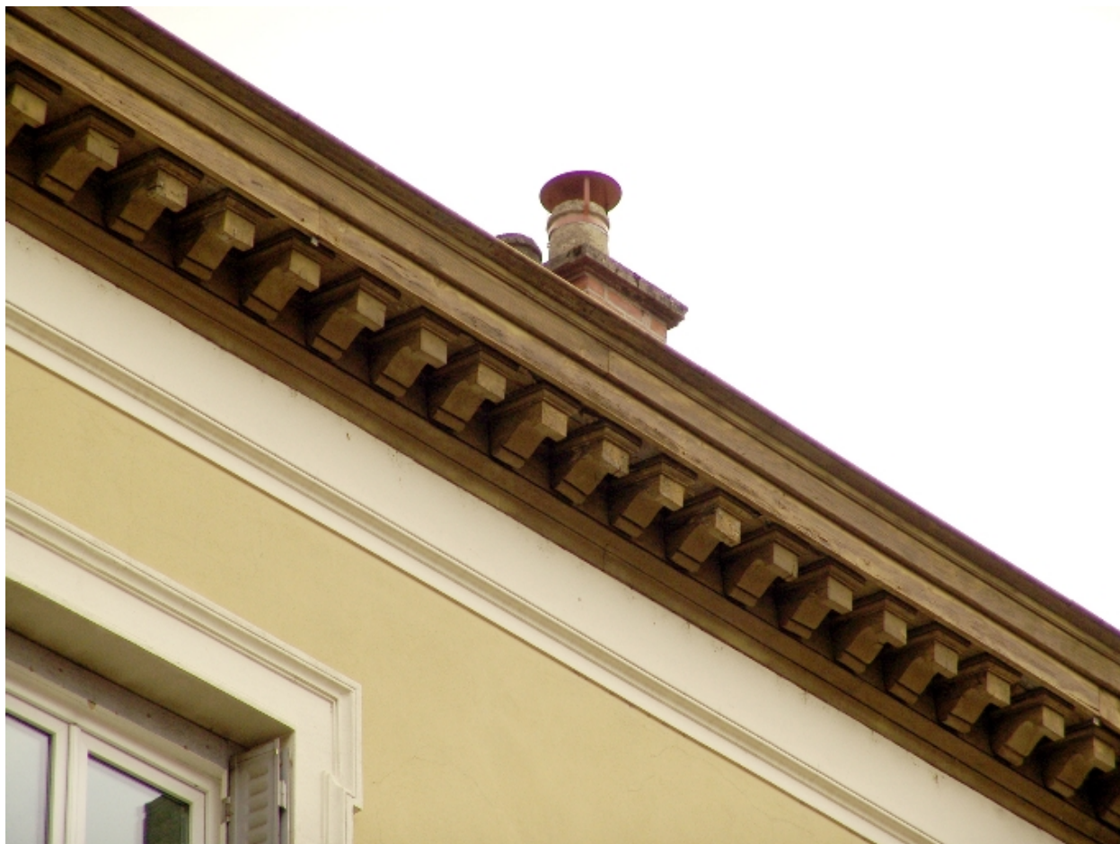
Détail de la corniche
