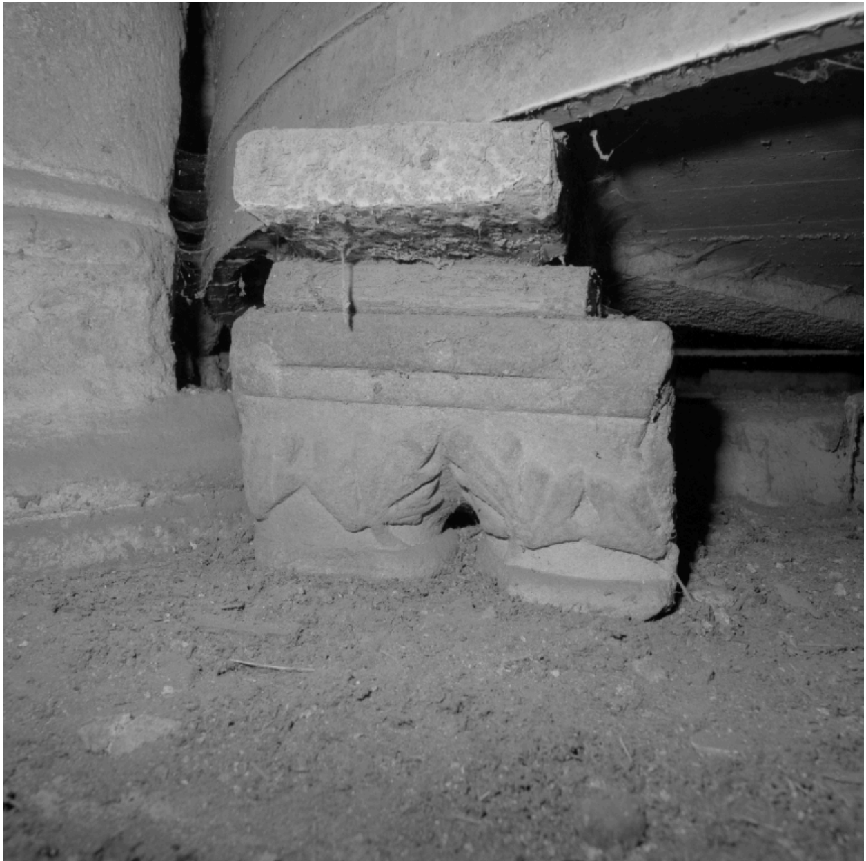
Chapiteau géminé utilisé comme cale de l'une des cuves dans l'abside.
