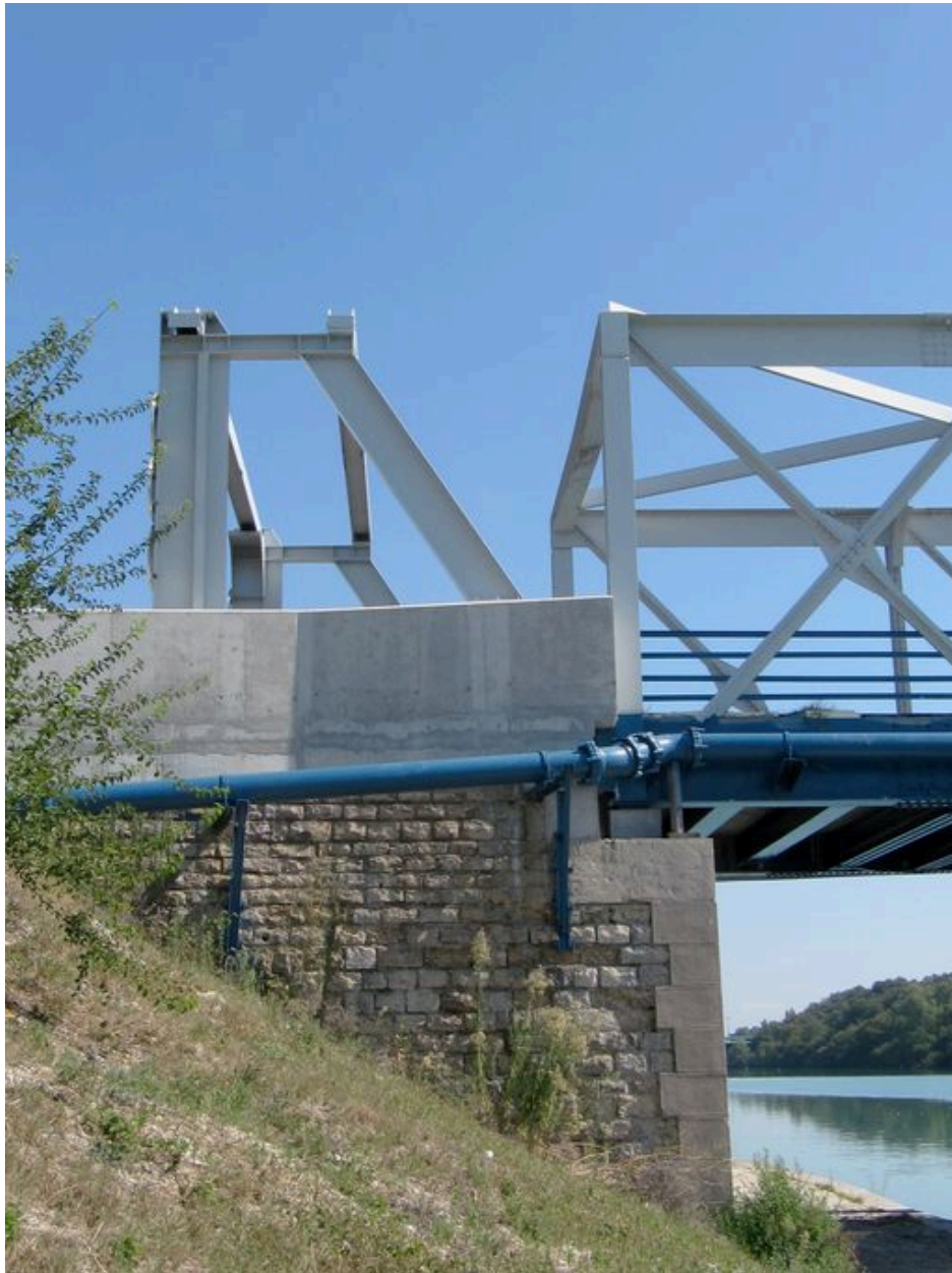
Culée droite, face aval, vue générale (depuis la rive droite)
