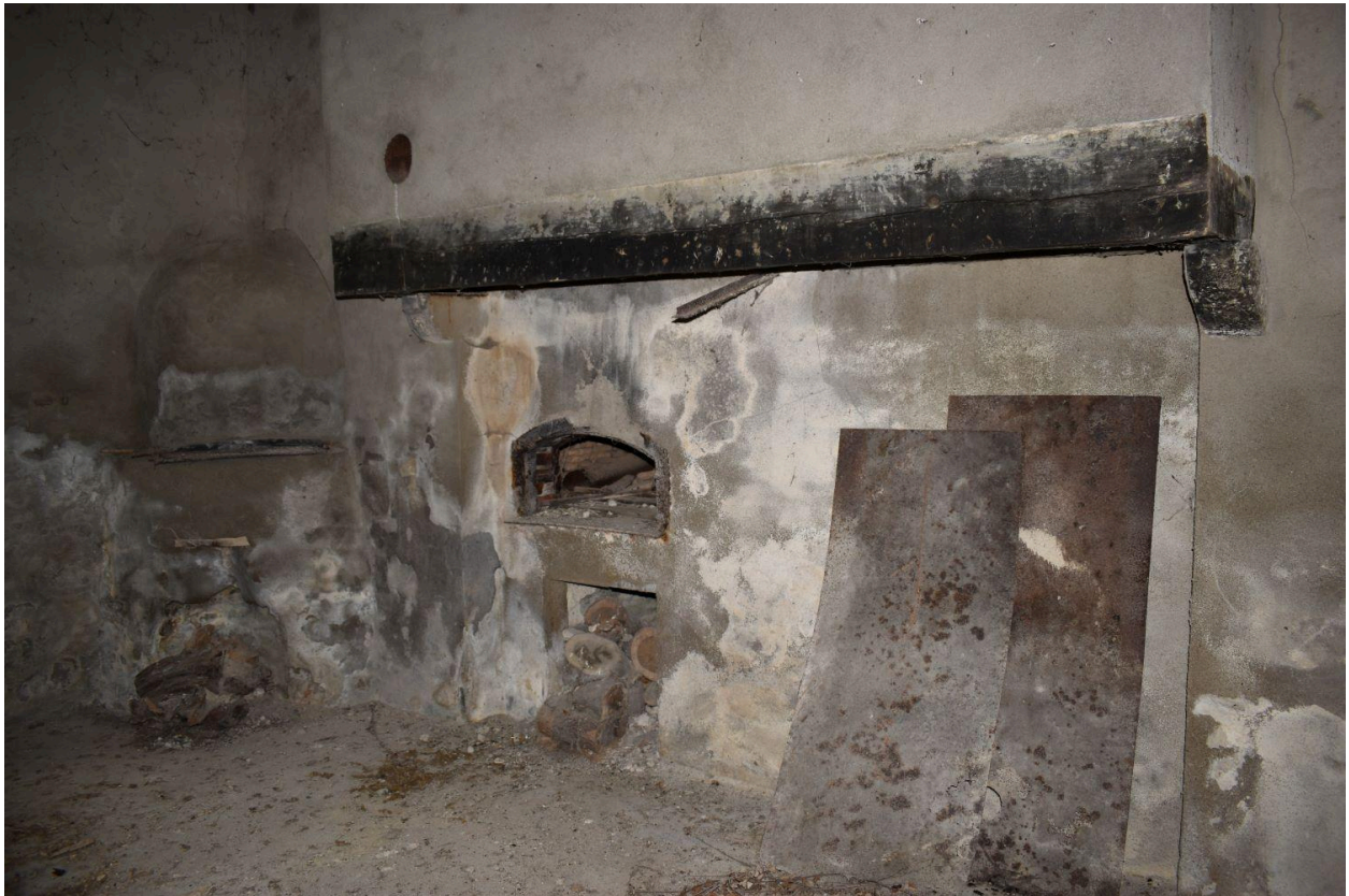
Vue intérieure de la pièce du four (cuisine?)
