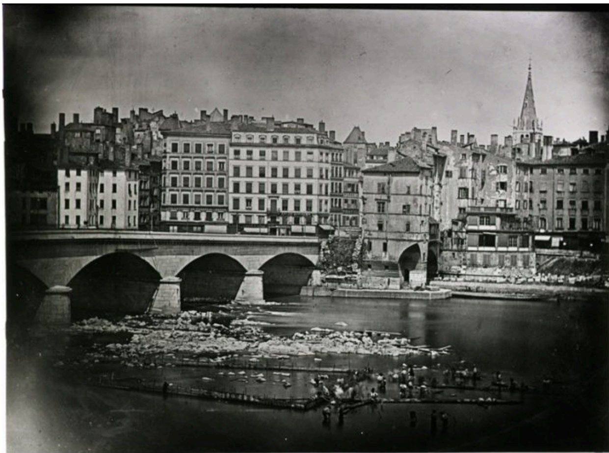
Démolition du Pont du Change, photogr., ca 1846-1847
