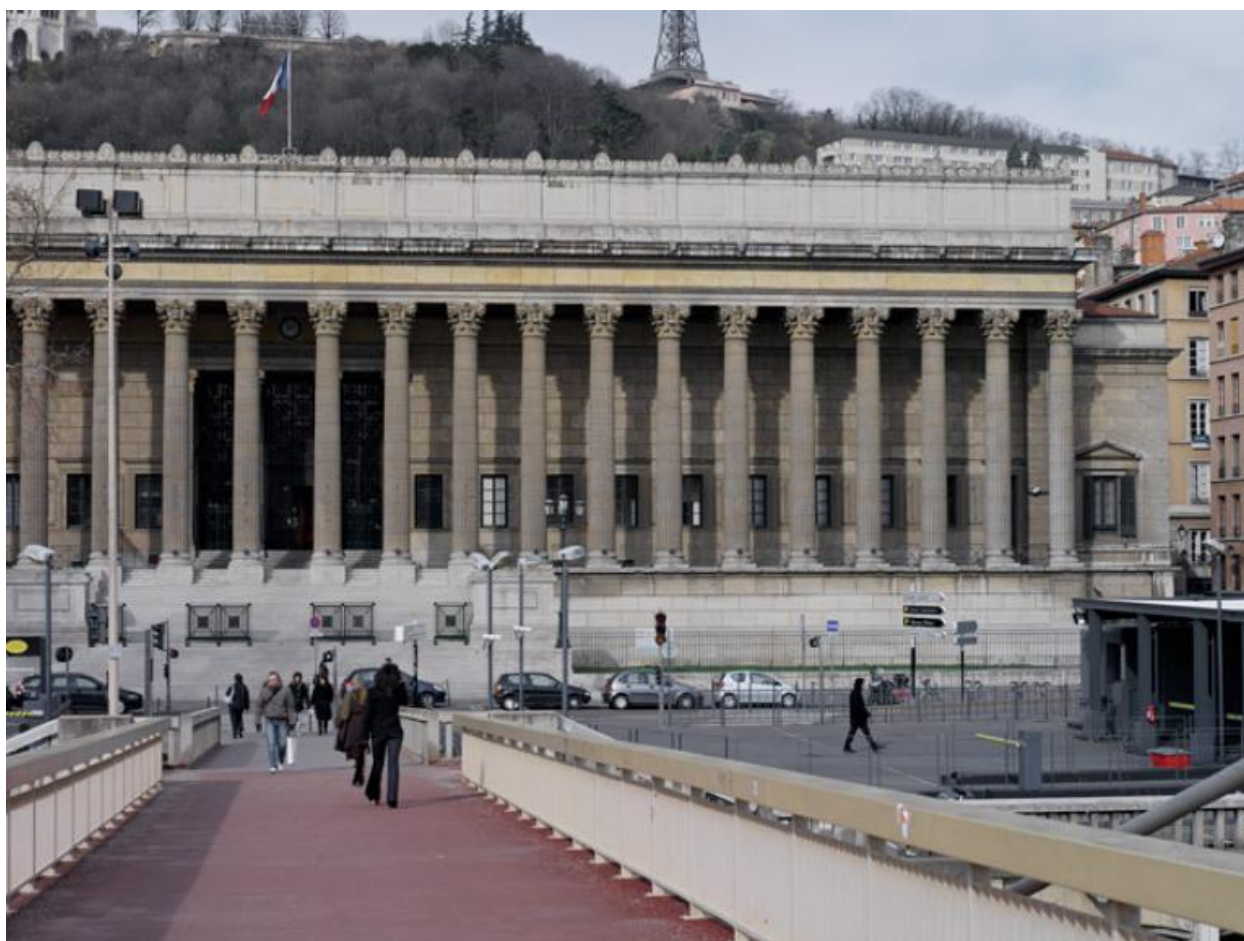
L'élévation antérieure : partie nord
