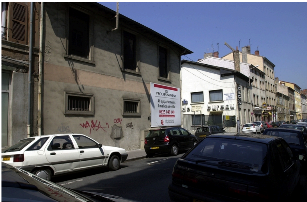
Vue générale est
