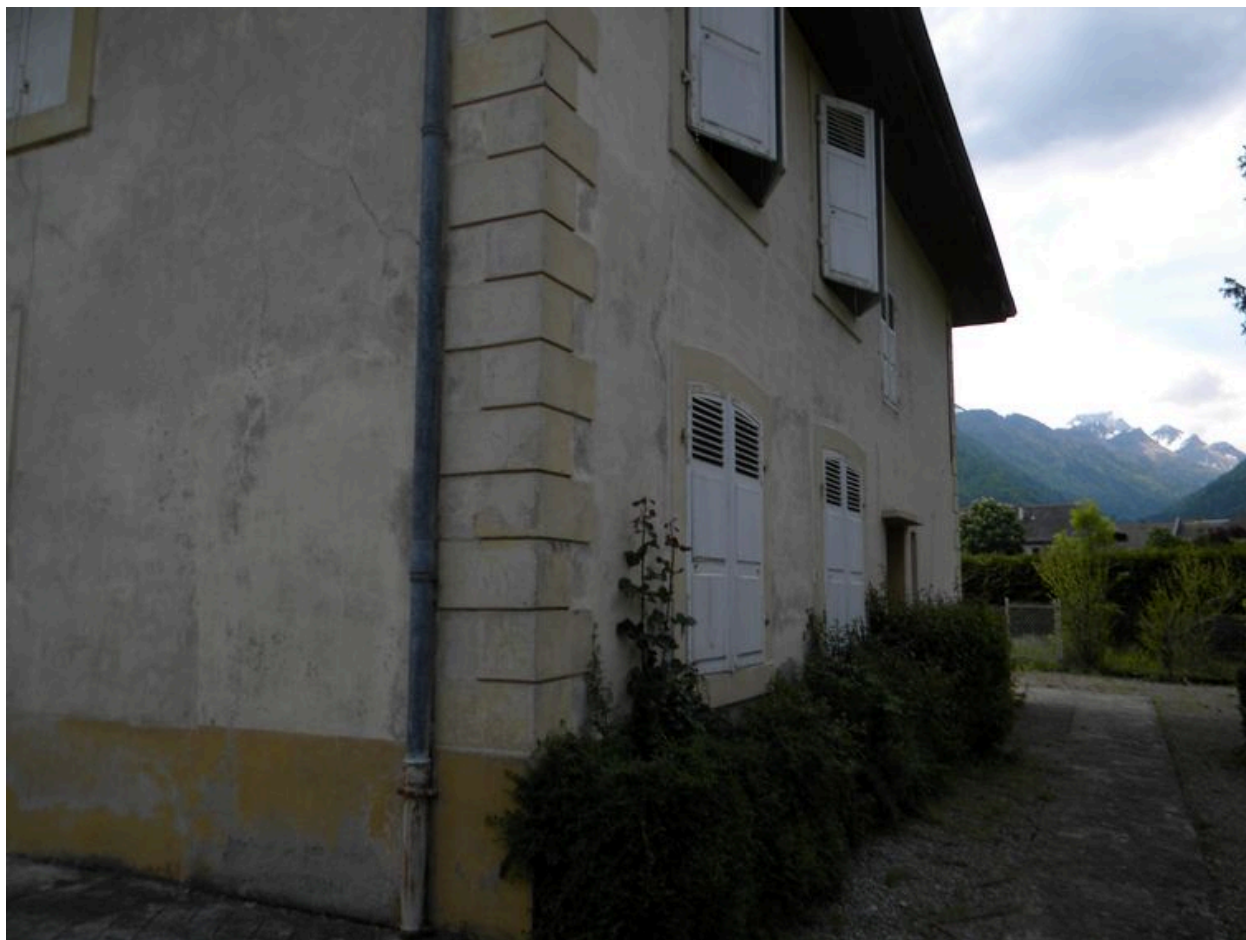
Détail d'un chaînage d'angle.
