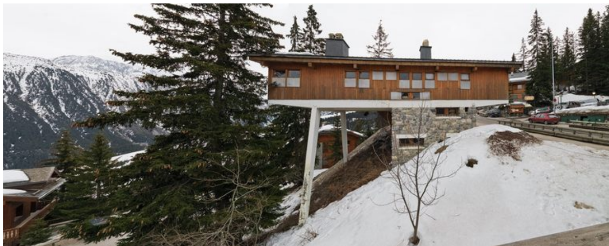
Vue générale depuis le nord
