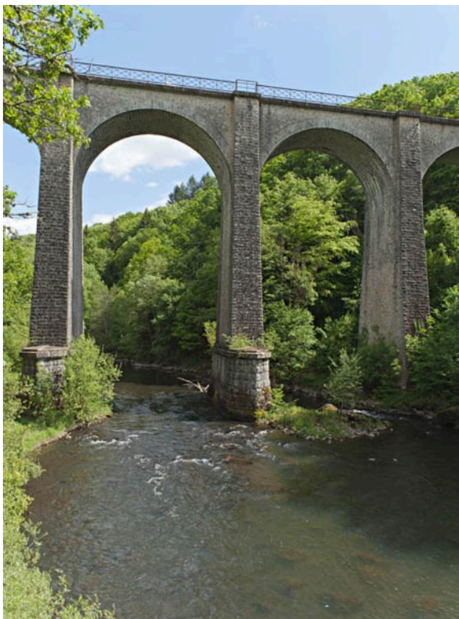
Vue du viaduc de Nèpes, côté amont, depuis les rives de la Cère.
