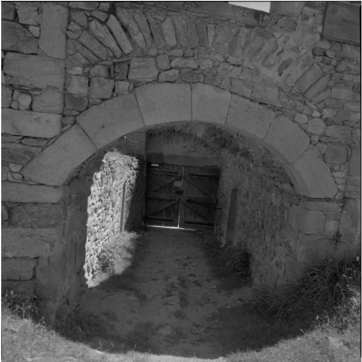
Côté nord-est de la première enceinte, ouvrage d'entrée : détail de la voûte en berceau arrachée vue depuis l'intérieur du premier baile, du sud-ouest.
