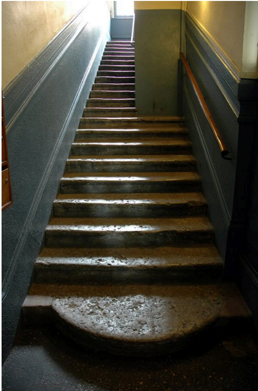
Départ de l'escalier principal
