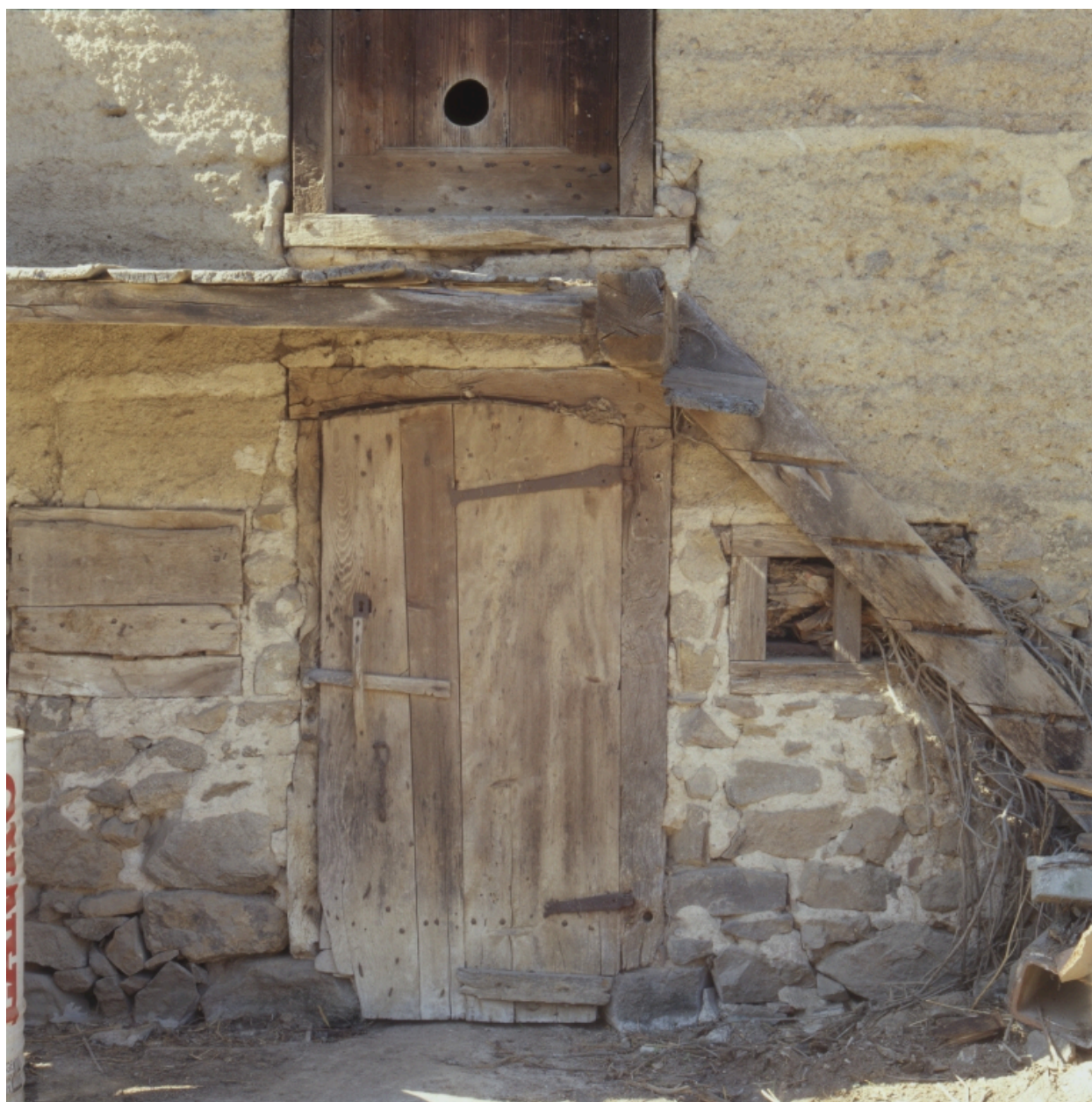
Bussy-Albieux, Gouttebelin, ferme (1987 D2 693). Bâtiment ouest, façade est.
