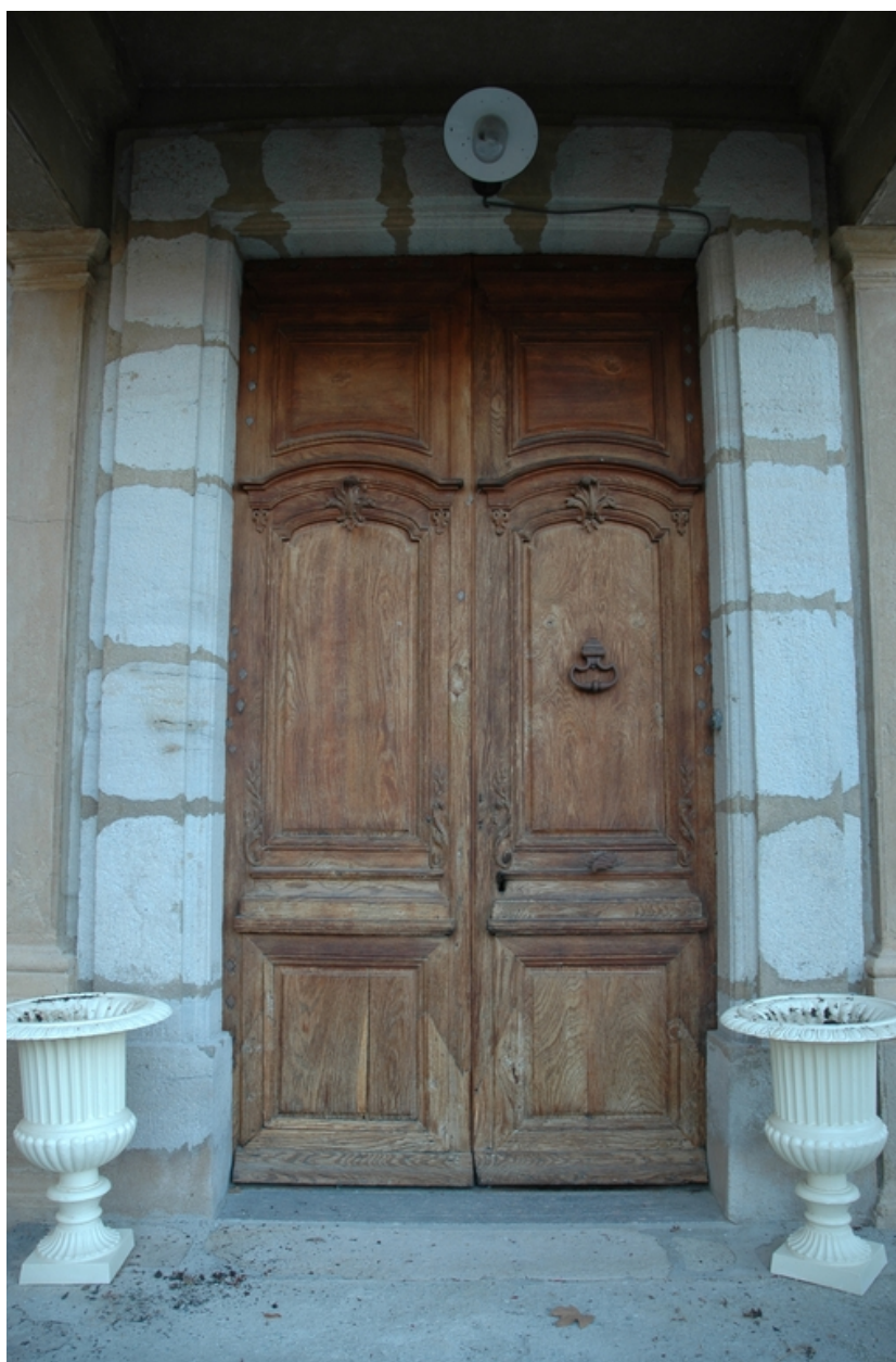
Détail de la porte d'entrée.
