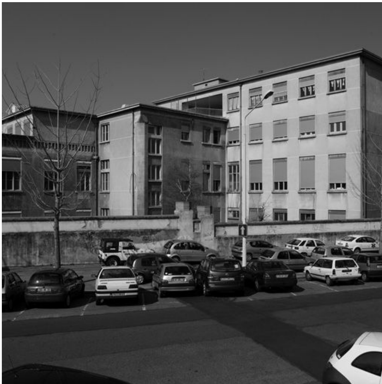
Le pavillon U. Vue d'ensemble depuis le sud-est rue Viala
