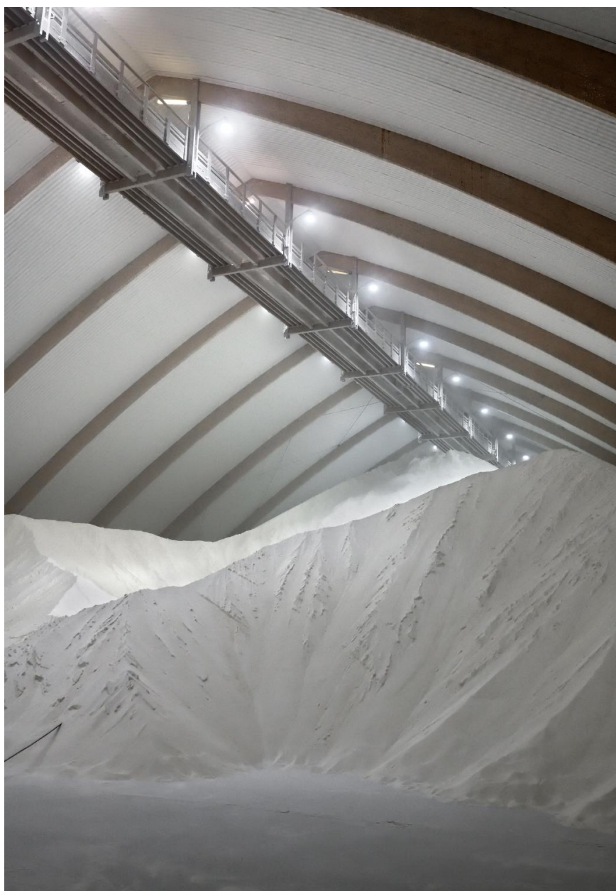
Silo : détail charpente en bois de forme parabolique
