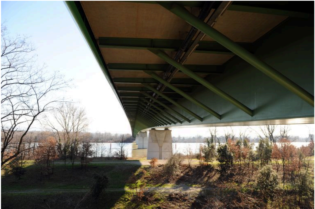
Vue partielle, de dessous, moitié gauche du tablier (depuis la rive droite)
