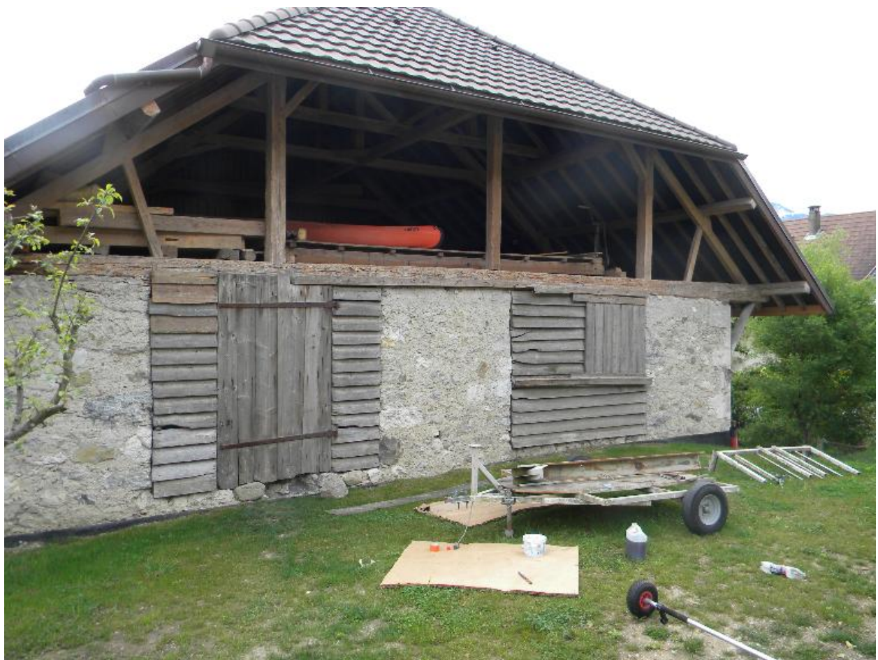
Vue du pignon ouest des bâtiments agricoles.
