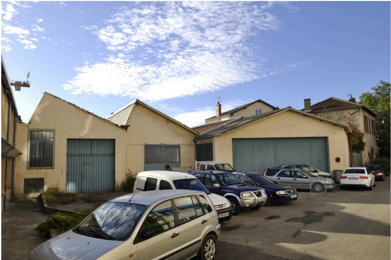
Vue d'ensemble sud
