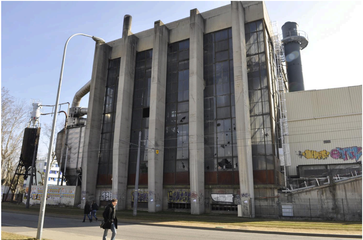
Vue latérale de la chaufferie
