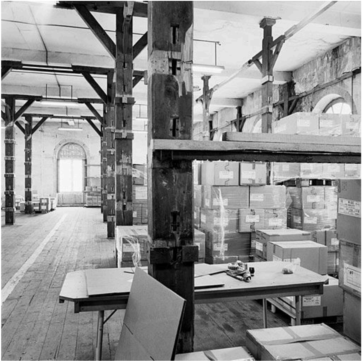
Bâtiment de stockage: salle du premier étage 2
