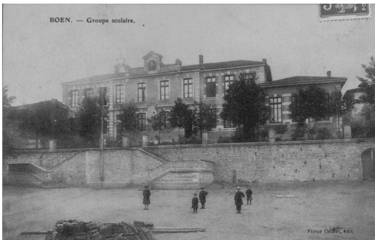
BOËN. - Groupe scolaire.". Vue générale de la façade, du sud-est.
