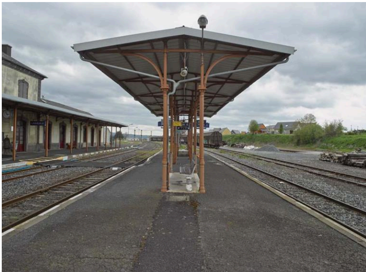
L'abri de voyageurs à structure métallique de la gare de Laqueuille.
