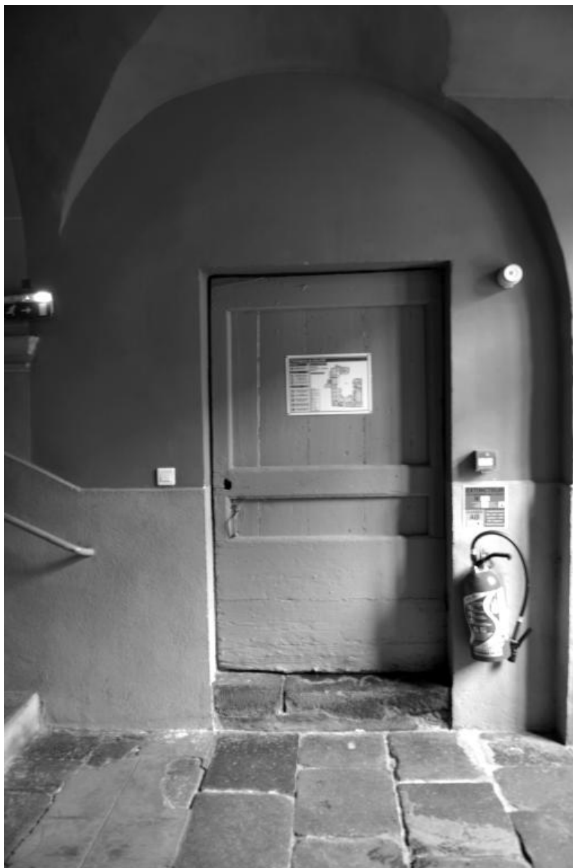
Porte jouxtant le départ de l'escalier principal, conduisant au réfectoire
