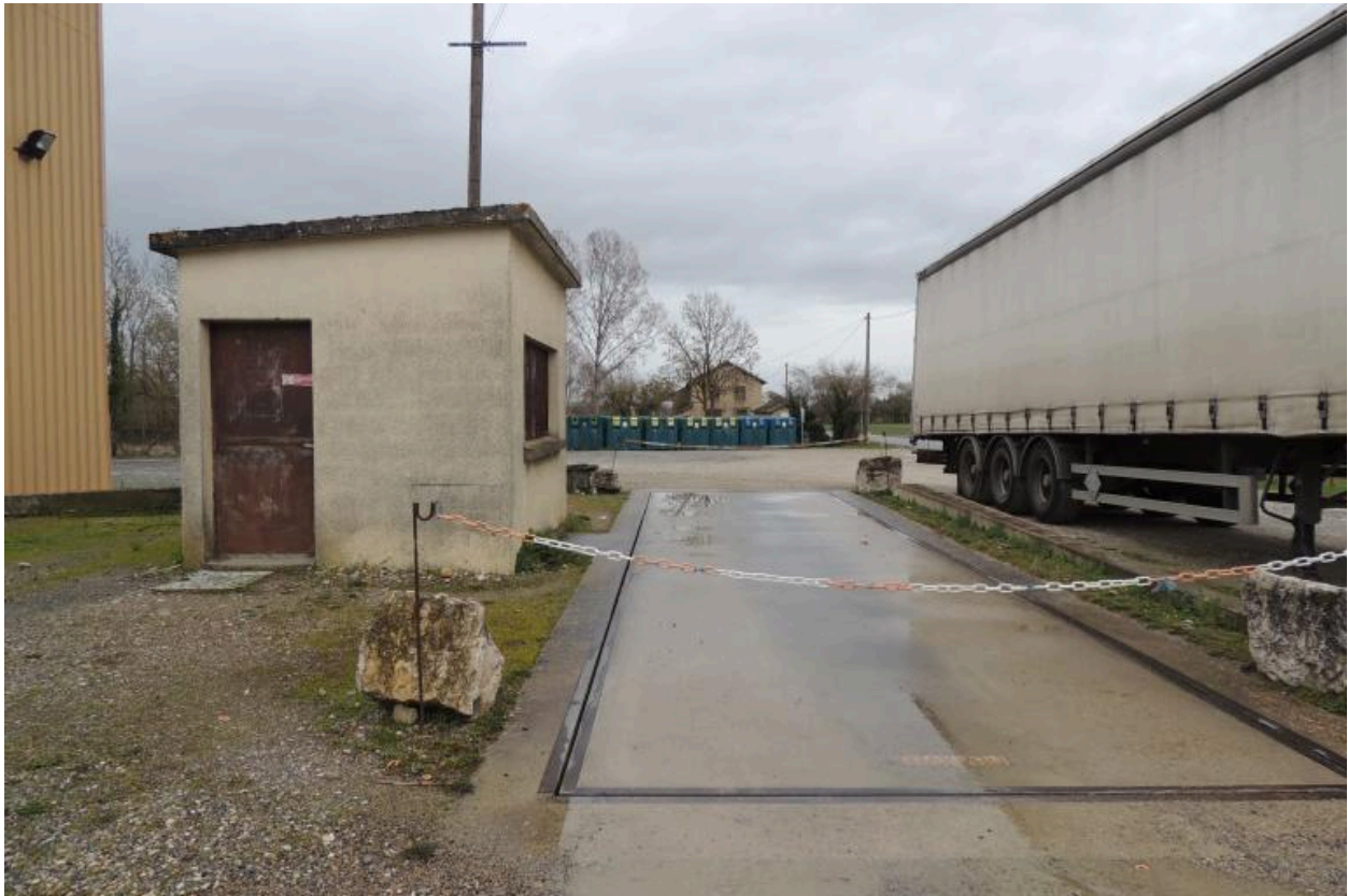
Vue d'ensemble : cabine de pesage et plateforme.
