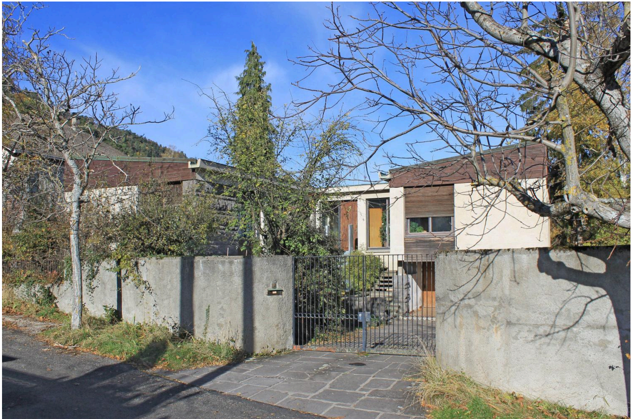
Ceyrat, la maison L. vue depuis l'allée des Noyers (depuis le sud-est), avec son mur de clôture et sa barrière en ferronnerie dessinée par Paul Lanquette.
