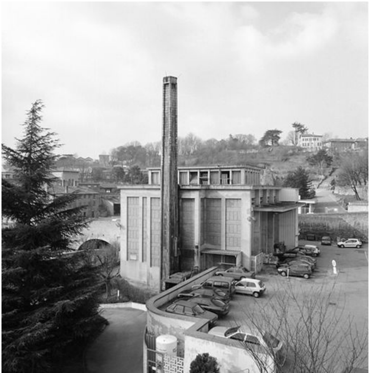
Chaufferie (25), vue générale sur l'angle nord-est
