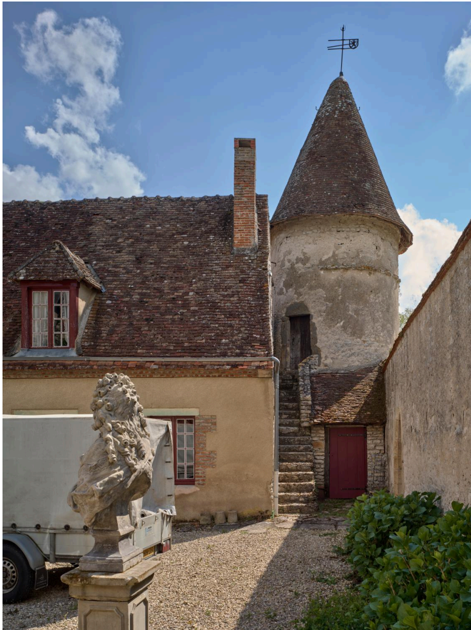
Tour sud, vue de l'ouest.
